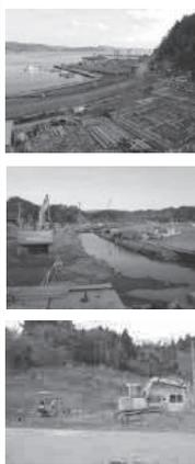
石巻市の半島部で予定している倉庫再建支援の建設工事が始まりました。21日に折浜・荻浜という2か所の建設現場を見に行きました。どちらも漁港の復旧はまだまだという状況です。荻浜では、沈下した船着き場を取り壊して新しい船着き場を作る作業が進んでいました。港には新しい船が泊まっていました。かさ上げ工事等、漁港の復旧をしながらの工事のため、だいぶ予定から遅れましたが、着工してひとまず安心しました。他の8カ所の建設も、早く着工するよう祈っています。
