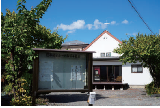
松本教会外観
