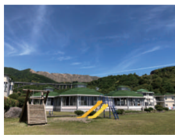
別府平和園建物外観
