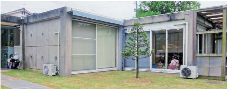
慈愛園乳児ホームと共同で使用している建物
