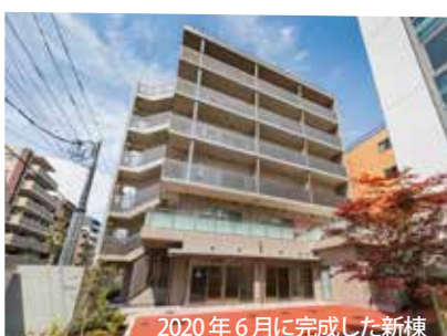
2020年6月に完成した新棟
