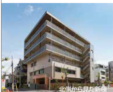
北側から見た新棟
