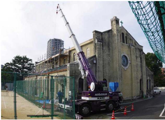
11月 復旧工事を急ぐブラウンチャペル
