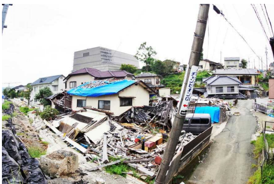
9月 倒壊家屋がそのまま残る益城町にて
